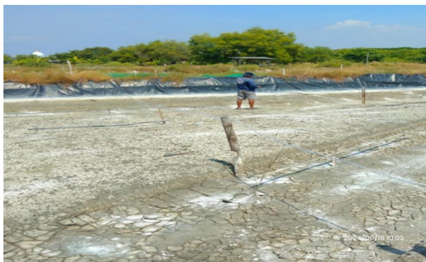
Gambar 9 Pemasangan pipa aerasi
